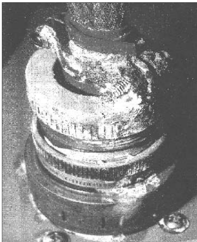
Un classico esempio di corrosione galvanica dovuta a metalli diversi utilizzati su uno stesso assemblaggio.
